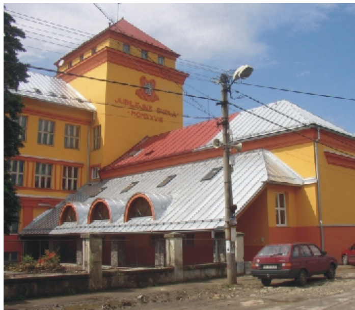
Foto - budova GBAS po rekonštrukcii
